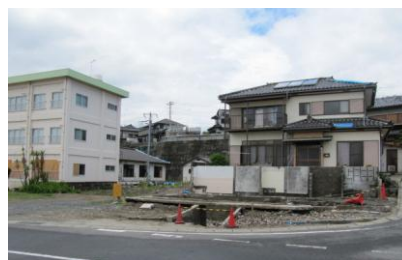
写真2 津波による被害 (D地区)
